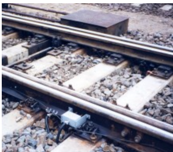
Beépített váltófűtés
